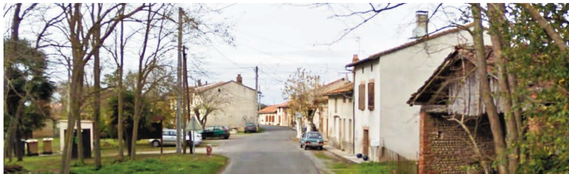
Constructions anciennes le long de la RD35e
