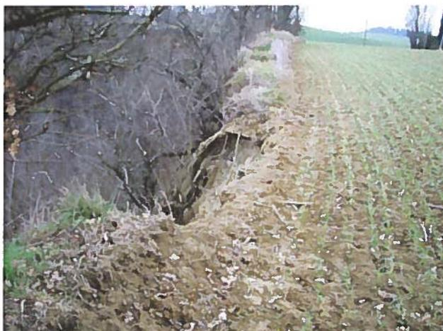
Arrachements et éboulements superficiels, conduisant à un léger recul de la crête
